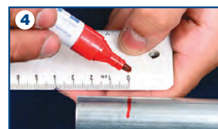
4- Marquage de la profondeur d'insertion
