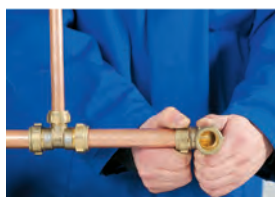
3. Insérer le tube dans le raccord
