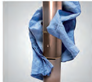
8. Attendre que le soudure refroidisse. Pendant le refroidissement, ne pas déplacer ou tordre les composants. Puis, enlever les résidus de flux.
