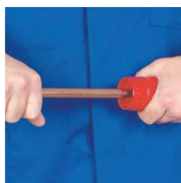
2. Ebavurer soigneusement le tube intérieur et extérieur (les tubes en cuivre recuit doivent être calibrés)
