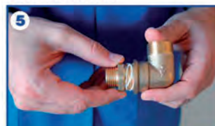
5- Visse et serrer le raccord avec une clé à molette jusqu'à étanchéité
