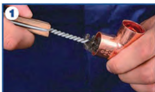
1 - Nettoyer à l'intérieur du raccord
