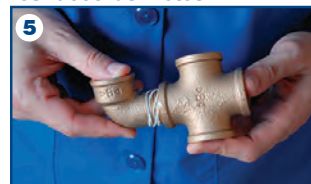
5- Visse et serrer le raccord avec une clé à molette jusqu'à étanchéité
