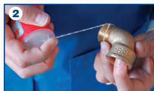
2- Appliquer du ruban PTFE ou filasse + pâte à joint sur les raccords filetés
