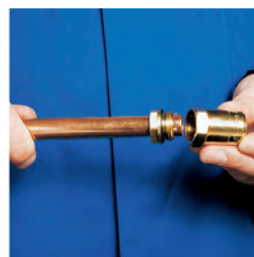
6. Visser manuellement le raccord sur la terminaison
