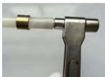
2. Elargir le tube avec l'outil évaseur
