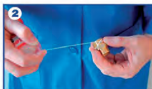
2- Appliquer du ruban PTFE ou fillasse + pâte à joint sur les raccords filetés
