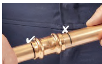
5. Insérer le tube dans le raccord
