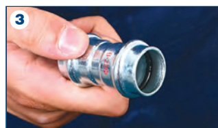
3- Vérification du joint torique
