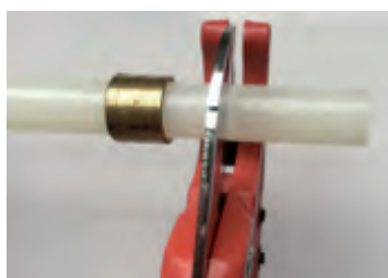
1. Couper le tube à 90° et monter la bague sur le tube
