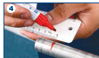
4- Marquage de la profondeur d'insertion
