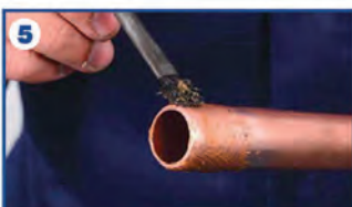
5 - Appliquer le décapant
