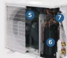
La pompe à chaleur fonctionne grâce à un fluide frigorigène qui circule dans un condenseur autour de la cuve.
