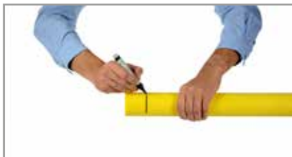
7. Marquer la profondeur d'insertion du tube.
