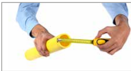
1. Mesurer le diamètre du tube.
