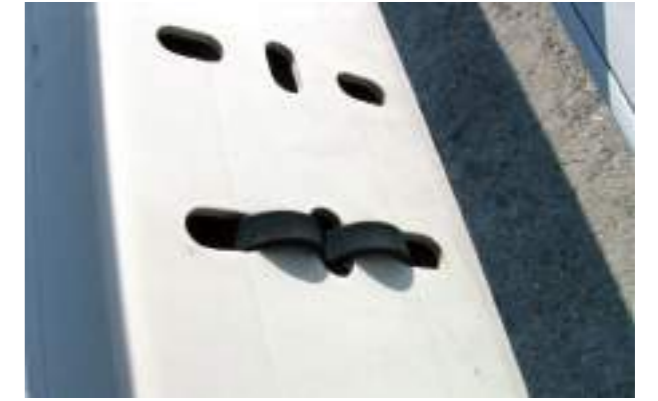
Traitement de l'eau
