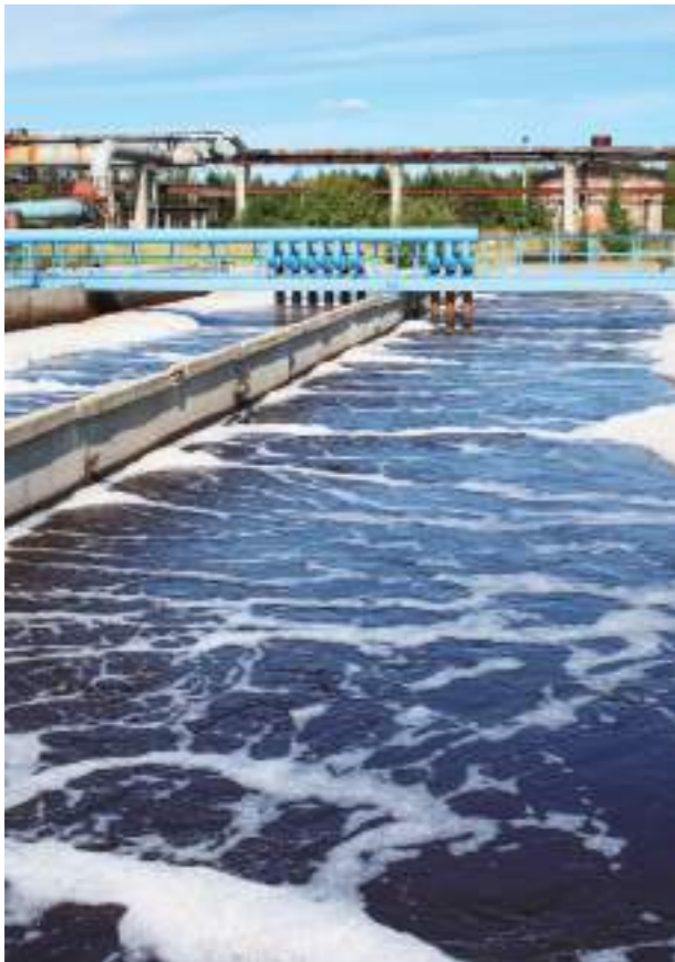
Traitement de l'eau
