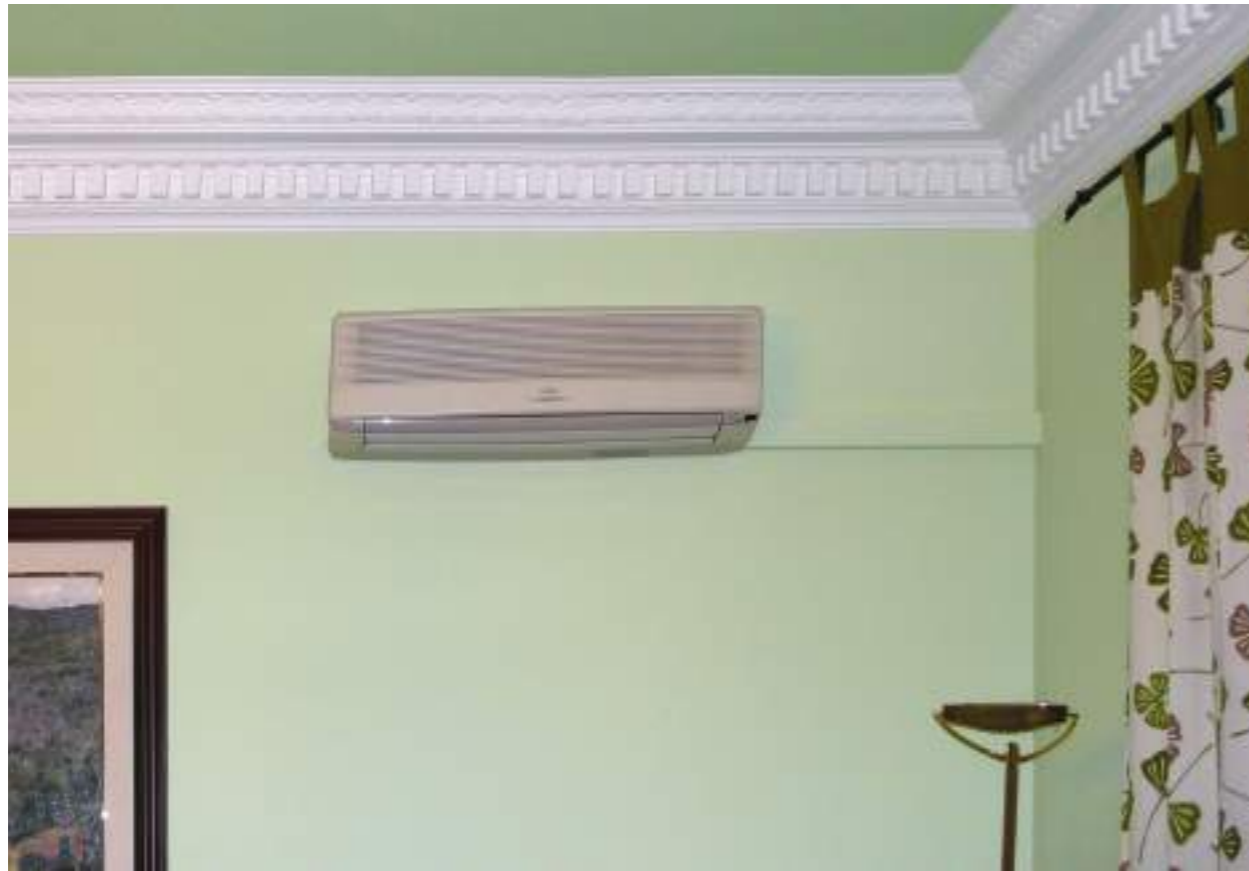
Réhabilitation de logement
