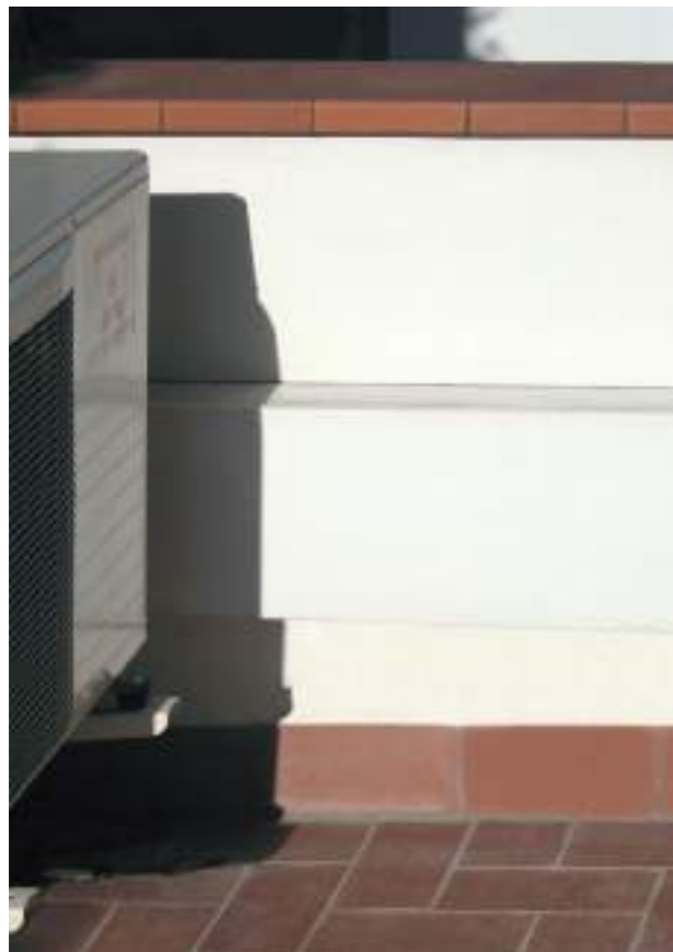
Réhabilitation de logement
