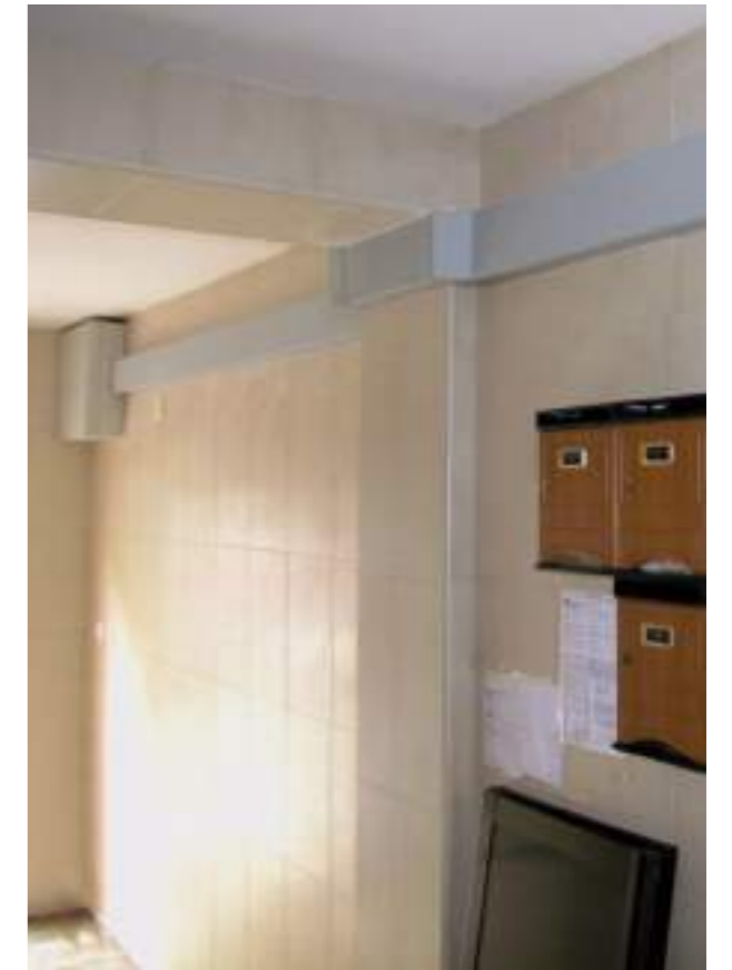
Réhabilitation de logement
