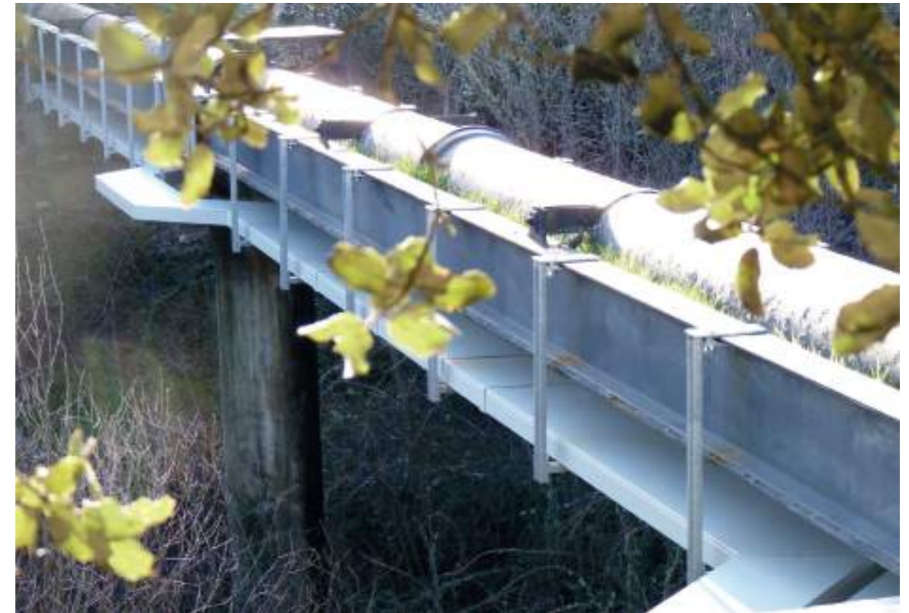
Distribution d'énergie électrique
