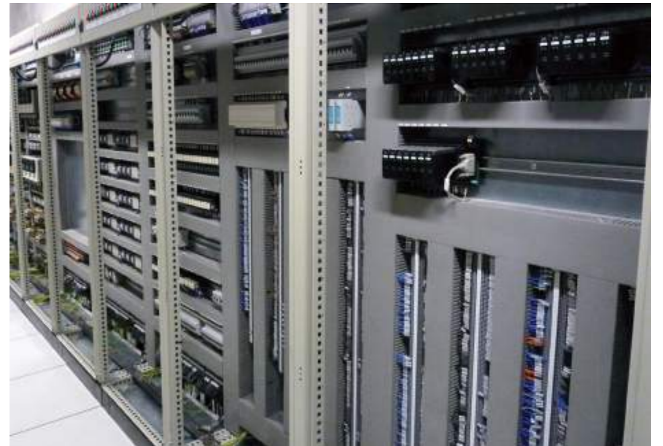
Traitement de l'eau
