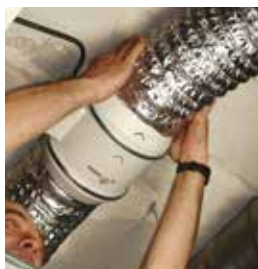
Raccorder les conduits.
