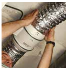
Raccorder les conduits.
