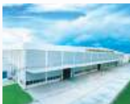
Usine de Chonburi en Thaïlande
