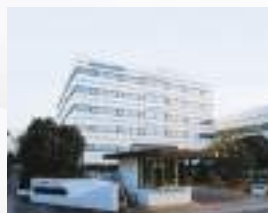
Usine de Shizuoka au Japon
