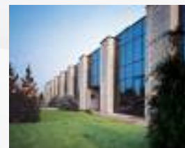
Usine de Pavie : IT Cooling
